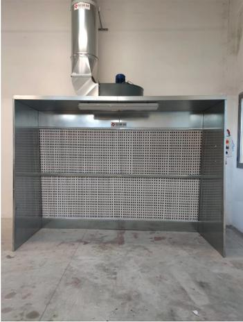
Exemple d'installation de cabine de pulvérisation avec des extensions et un toit, relié à une cheminée d'expulsion.
