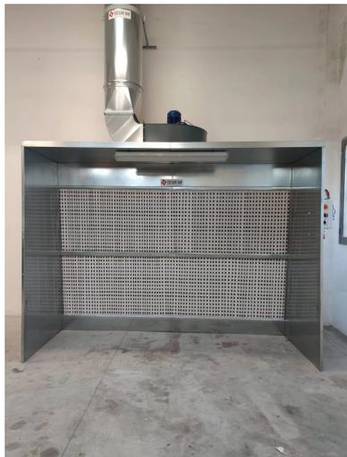
Exemple d'installation d'une cabine de pulvérisation avec extensions et toit, avec éclairage et panneau de commande.
